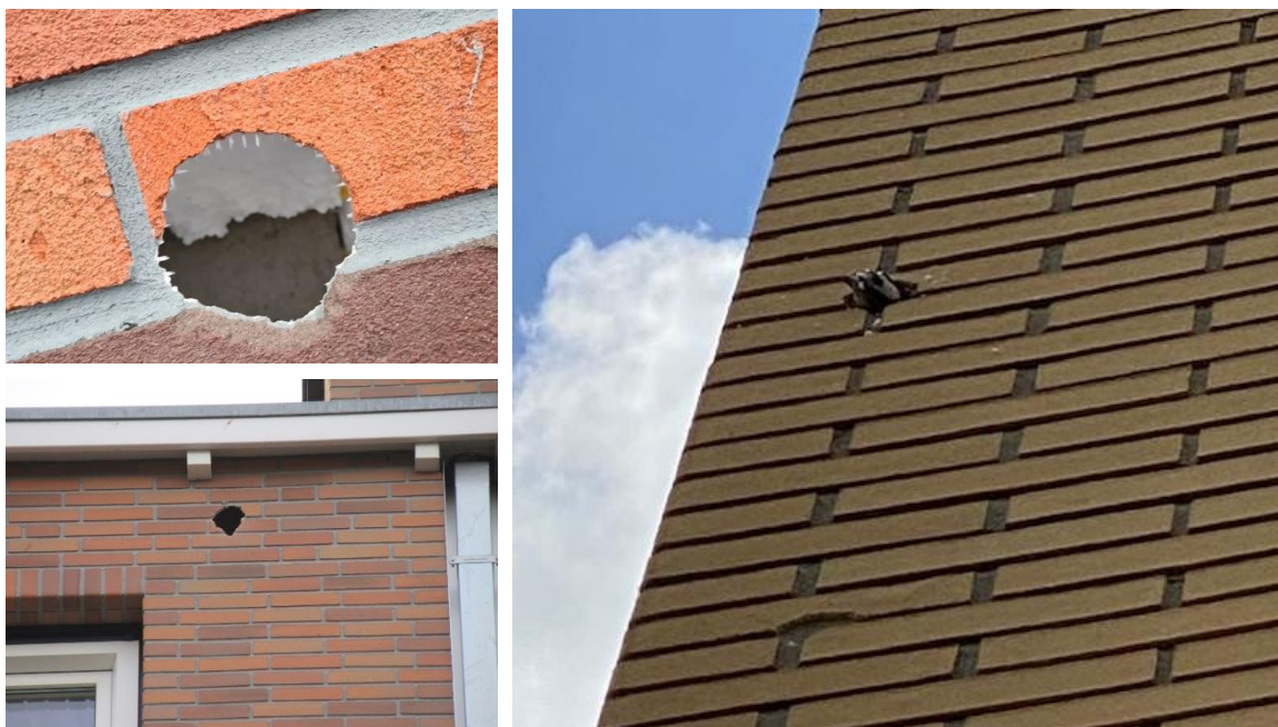
Figuur 1-1: Voorbeelden van spechtschade in de gevelstrips. In de linker foto is een specht actief bezig een nest te maken.
