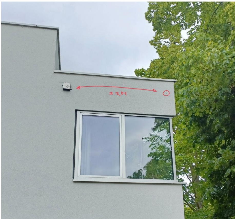
Figuur 3-7 Ultrasoon apparaat en gat van een specht bij de woning aan de Kappeyne van de Coppellostraat
